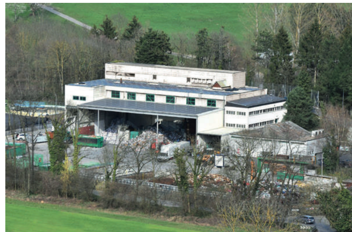
Le site d'exploitation de Valorsa s'étend sur une surface de 17'000 m 2
